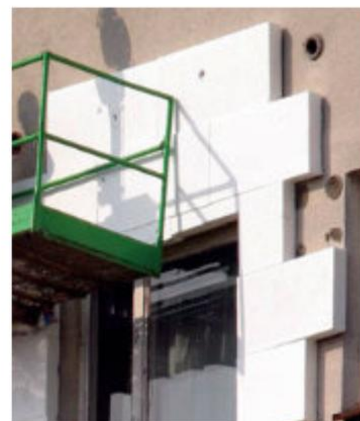
Dodatkowa warstwa izolacji cieplnej na ścianach budynku pozwala oszczędzać energię. Dzięki temu mieszkańcy płacą niższe rachunki za ogrzewanie i pomagają chronić środowisko.
