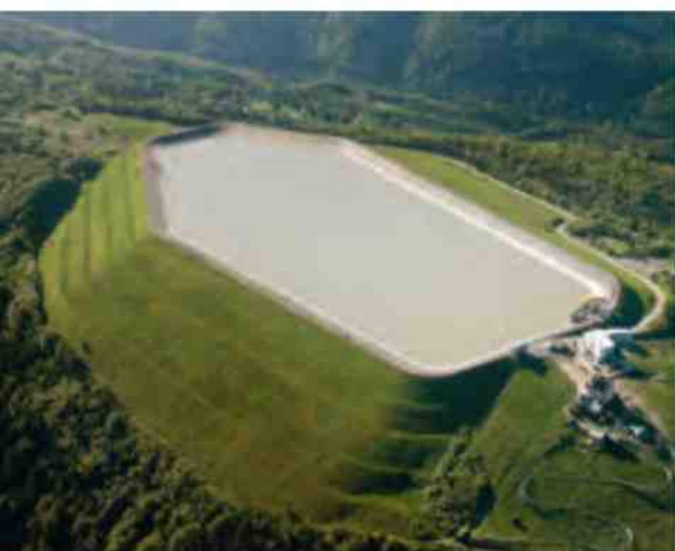
Zbiornik górny elektrowni szczytowo-pompowej Porąbka-Żar.
