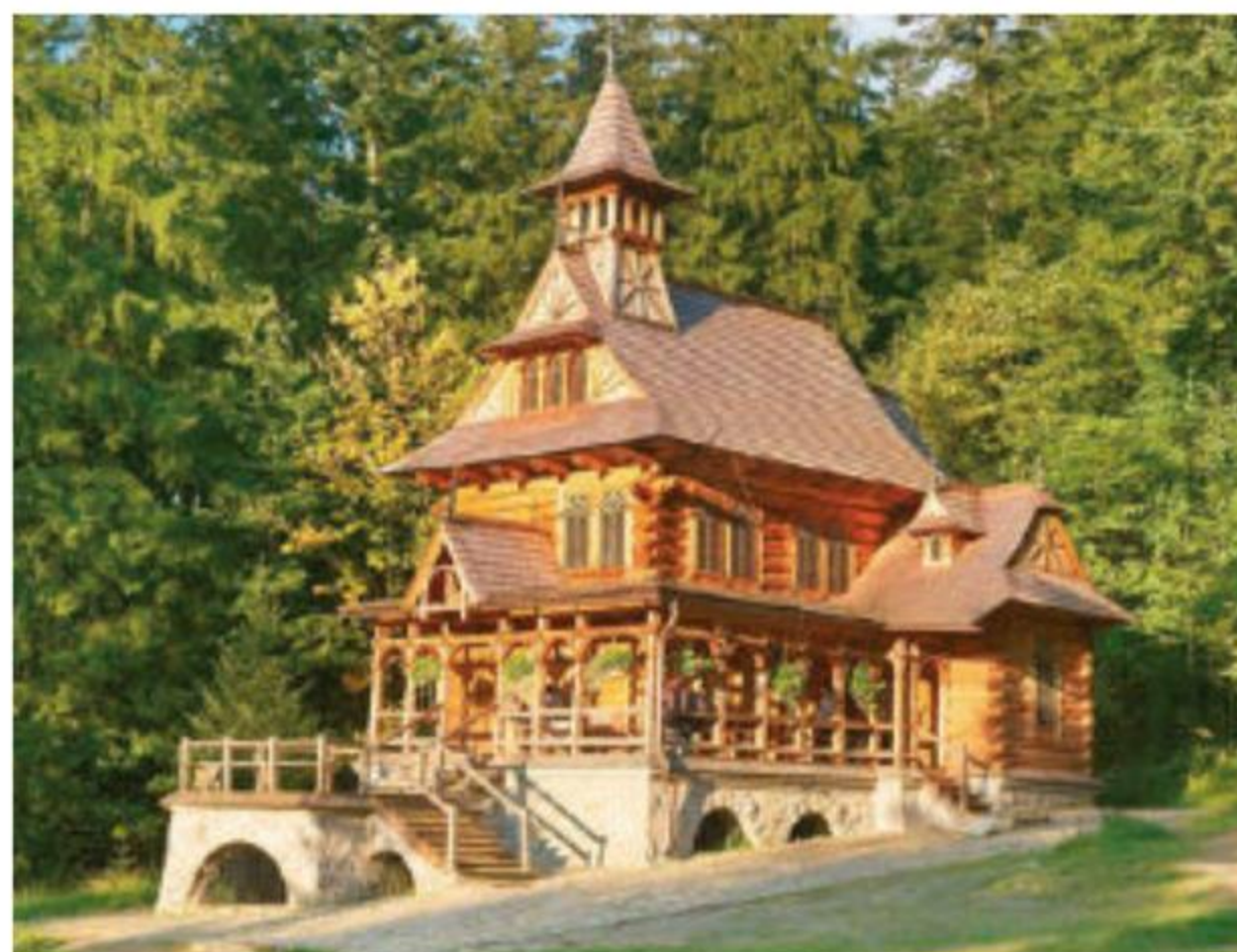
▲ Zbudowana na początku XX w. kaplica na Jaszczurówce jest przykładem budownictwa zakopiańskiego typowego dla Podhala.
