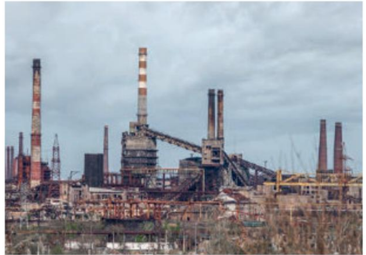
▲ W zakładach przemysłowych w Mariupolu przed wojną produkowano stal. W wyniku rosyjskiej inwazji te zakłady zrujnowano.
