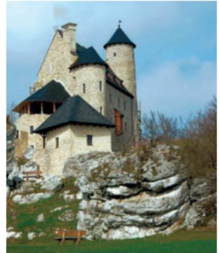
Zamek w Bobolicach powstał w XIV wieku. Jest jednym z tak zwanych orlich gniazd – zamków obronnych wzniesionych na pogranczu Małopolski i Śląska w trudno dostępnych miejscach, takich jak wysokie skały.
