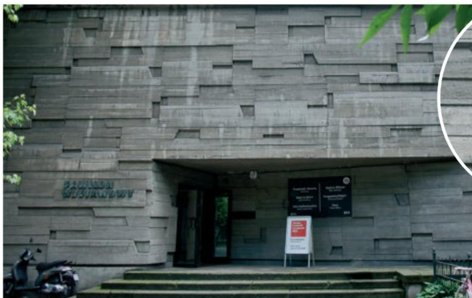
Krystyna Tołłoczko-Różyska, Antoni Hajdecki, Stefan Borzęcki, ściany Bunkra Sztuki w Krakowie, XX w.
