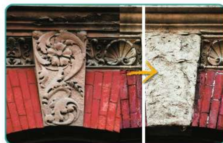
Niszczenie budynków i konstrukcji stalowych
