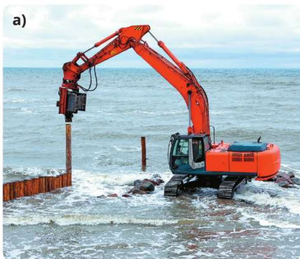
Ryc. 26.3. Kafar do wbijania pali falochronu podczas pracy (a) oraz nakręcanie zegarka ze sprężyną (b)
