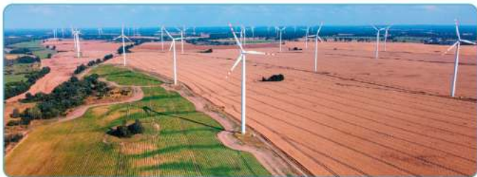
Elektrownia wiatrowa w Póbleciu w woj. pomorskim
