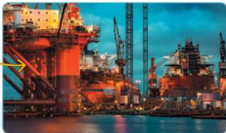
Platforma wiertnicza remontowana w gdańskiej stoczni
