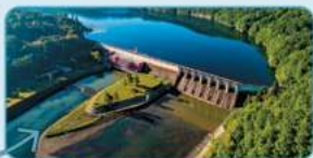
Elektrownia wodna na Dunajcu
