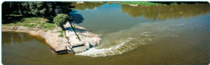
Zrzut ścieków do Wisły
