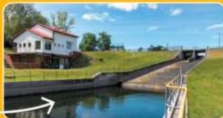
Zapora i elektrownia Myłof na Brdzie w woj. pomorskim
