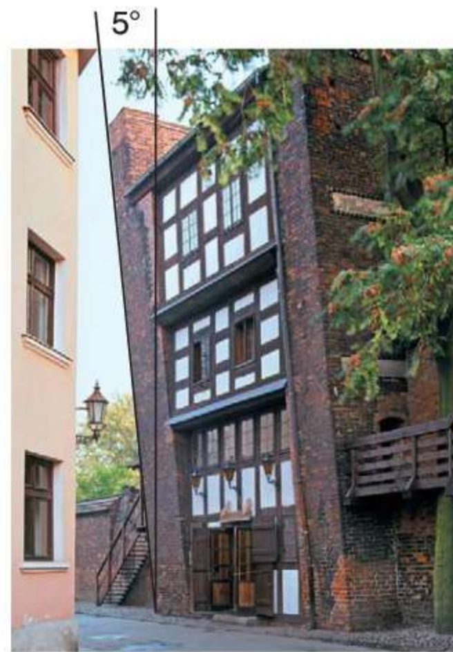
Średniowieczna baszta w Toruniu z XIII wieku ma odchylenie od pionu 5^\circ .
