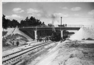
Budowa magistrały Śląsk–Gdynia, 1926
