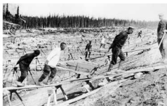
Więźniowie GULagu wykorzystywani do budowy kanału
