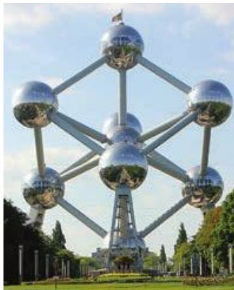
Fot. 13. Atomium – budowla w Belgii, która jest ogromnym modelem fragmentu kryształu żelaza. Każda z 9 kul symbolizuje atom żelaza.
