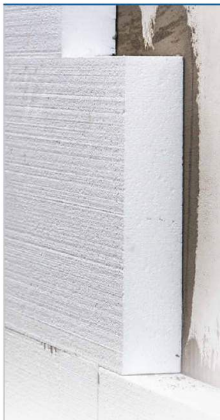
Fot. 36. Płyty styropianowe stosuje się głównie do ocieplania budynków.
