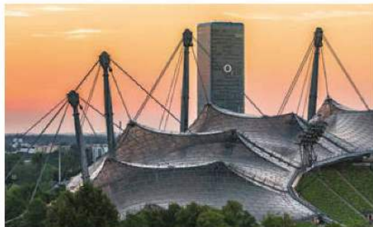
Fot. 111. Sklepienie Stadionu Olimpijskiego w Monachium wykonano w całości z PMMA.
