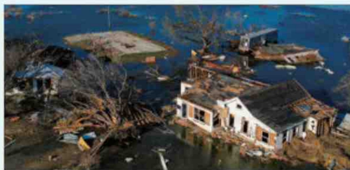
Stan po przejściu huraganu Delta, Louisiana (USA), 2020 r.
