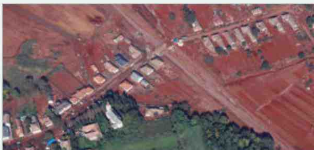
Skutki wycieku toksycznego szlamu po pęknięciu tamy zbiornika w hucie aluminium, Węgry, 2010 r.
