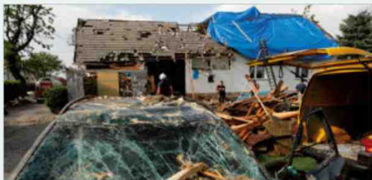
Skutki przejścia trąby powietrznej, Kaniów (woj. śląskie), 2020 r.
