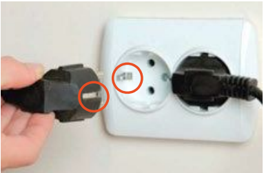
▲ Uziemienie może być też podłączone do styków z boku wtyczki
