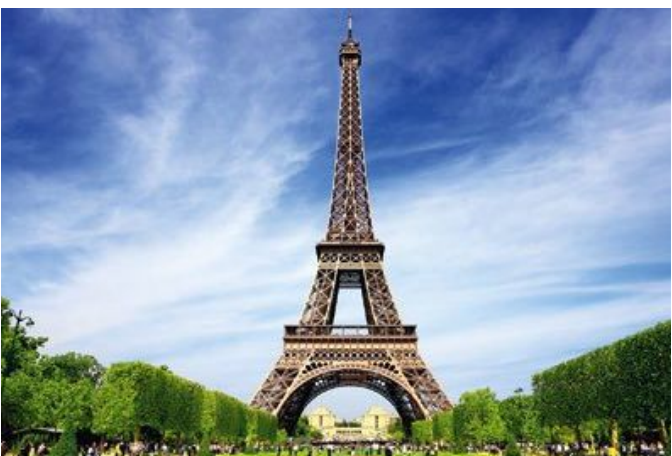
Wieża Eiffla została wybudowana w Paryżu w 1889 r. Składa się z ok. 18 tys. stalowych elementów.
