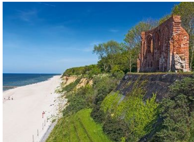
Kościół w Trzemeszynie został zbudowany na przełomie XIV i XV w. ok. 2 km od brzegu Bałtyku. W wyniku abrazji część świątyni runęła do morza. Obecnie można oglądać jedynie fragment jej ostatniej ściany.
