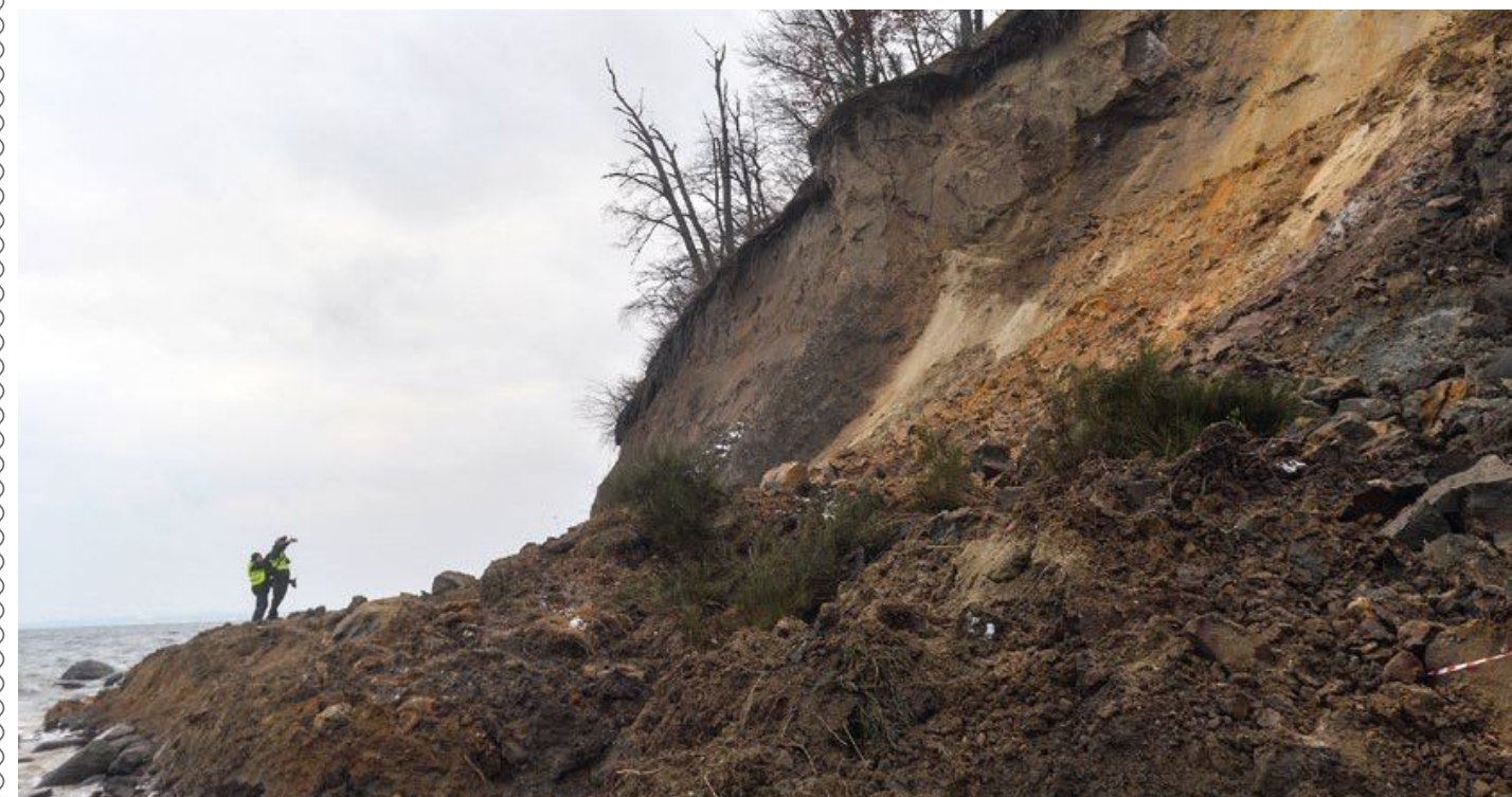
Obserwacja osuwiska na wybrzeżu w Gdyni-Orłowie w 2018 r.
