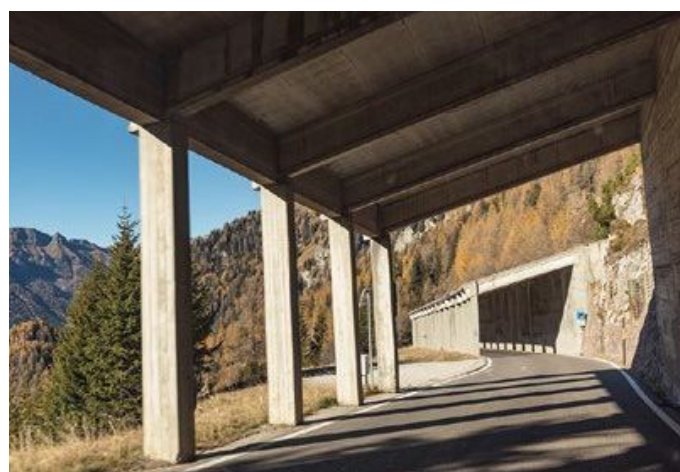
W miejscach, w których występują ruchy masowe, np. w Alpach, nad drogami buduje się specjalne osłony.
