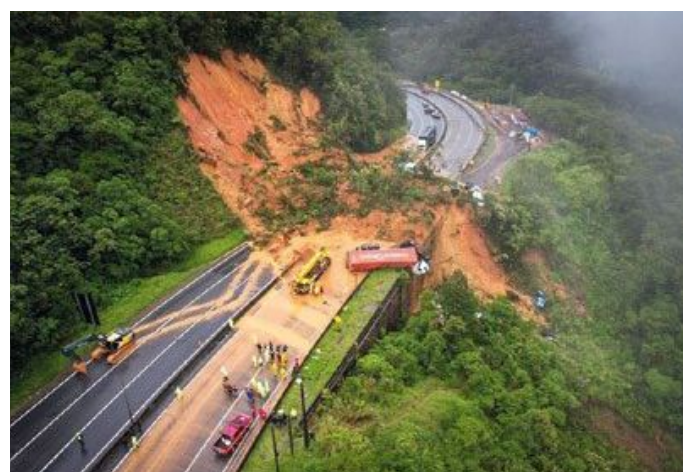
Każda droga wybudowana w poprzek stromego stoku jest narażona na wystąpienie ruchów masowych.
