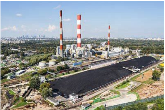
Elektrociepłownia Siekierki w Warszawie to druga co do wielkości elektrociepłownia w Europie.
