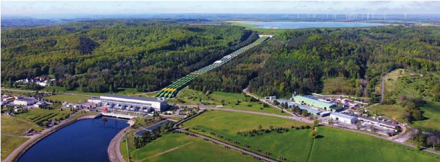
Jednym z rodzajów hydroelektrowni zbiornikowych są elektrownie szczytowo-pompowe, np. Elektrownia Wodna Żarnowiec (fot.). W takich zakładach wodę pompuje się do górnego zbiornika w okresie mniejszego zapotrzebowania na energię (np. nocą), a zrzuca do zbiornika dolnego, gdy zapotrzebowanie jest największe.
