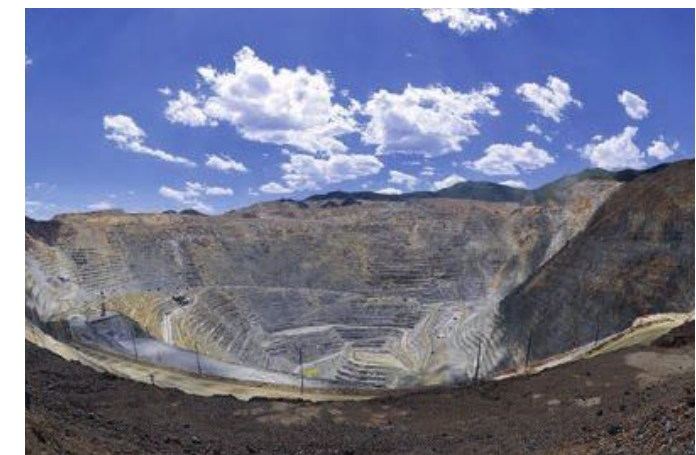
Kopalnia miedzi Bingham Canyon Mine (USA) ma szerokość ok. 4 km i głębokość ponad 1,2 km. To największa kopalnia odkrywkowa świata.
