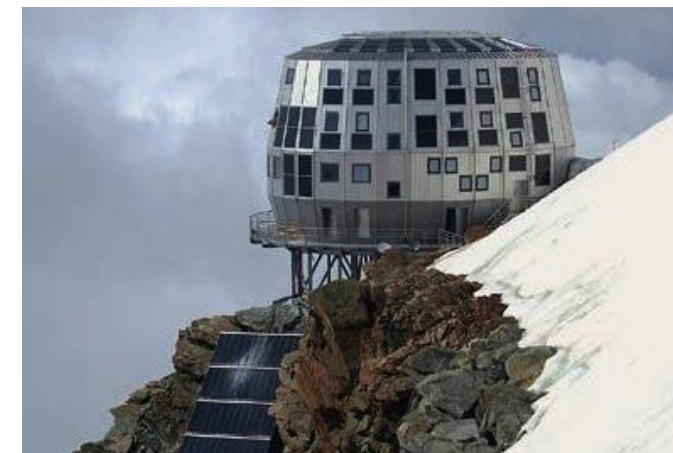
W schronisku turystycznym Goûter [wym. gute] w Alpach do wytwarzania energii elektrycznej i ciepła wykorzystuje się baterie słoneczne i olej roślinny.
