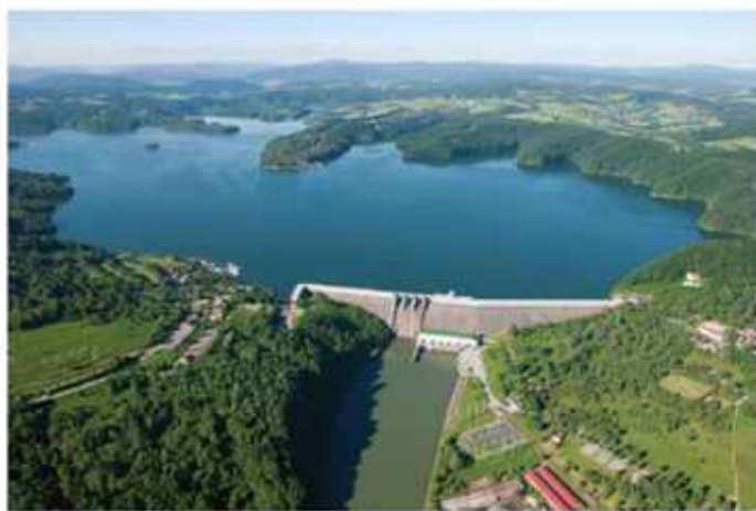
Jezioro Solińskie to największy sztuczny zbiornik wodny w Polsce (ma pojemność 472 mln m 3 wody). Jego powstanie było możliwe dzięki budowie najwyższej zapory w Polsce (82 m).
