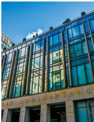
Siedziba Naczelnego Sądu Administracyjnego w Warszawie.
